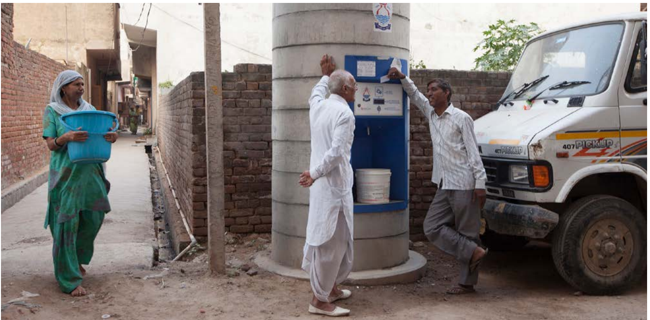
Les distributeurs automatiques solaires installés par une entreprise sociale à but lucratif appelée Piramal distribuent de l'eau potable propre via une carte à puce prépayée aux résidents qui n'ont pas accès à l'eau du robinet à domicile. New Delhi, India. (Photo par In Pictures Ltd./Corbis via Getty Images)
