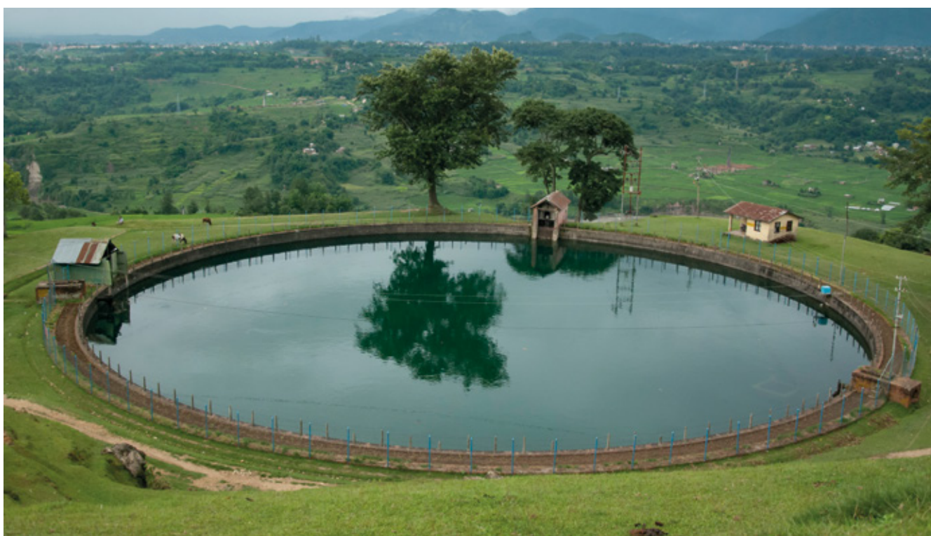
Petit réservoir d'eau pour l'énergie hydroélectrique, Népal
